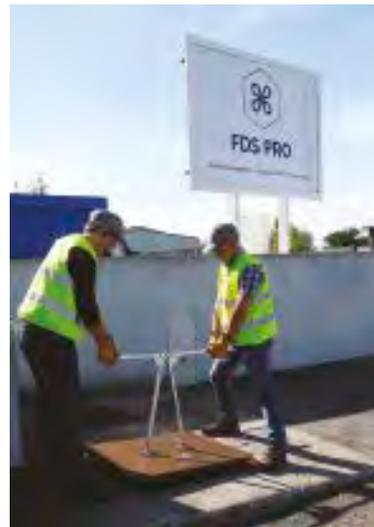
Souleveur magnétique double Ø 110 mm pliable
