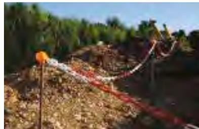
Embout de sécurité avec crochets pour fers à béton orange fluo
